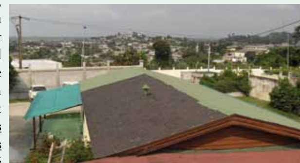
Le toit partiellement réparé de l'ancien garage, ainsi que les prolongements que nous avons du installer pour éviter les infiltrations.
