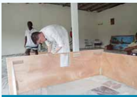
Construction de l'autel à la Pointe-Denis
