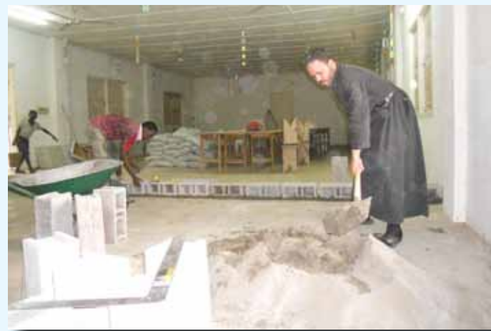
La chapelle en travaux...
